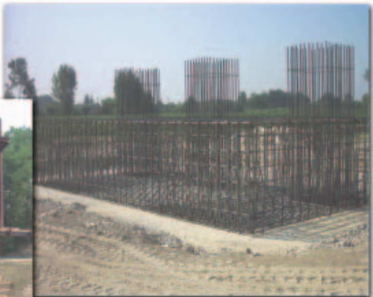
Armature ponte sovrappasso via Praimbole
