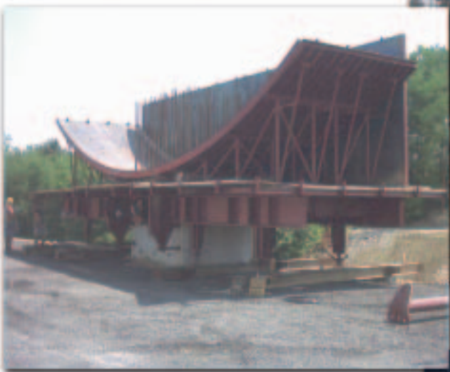
Cassero speciale per getto pulvino su pile centrali
