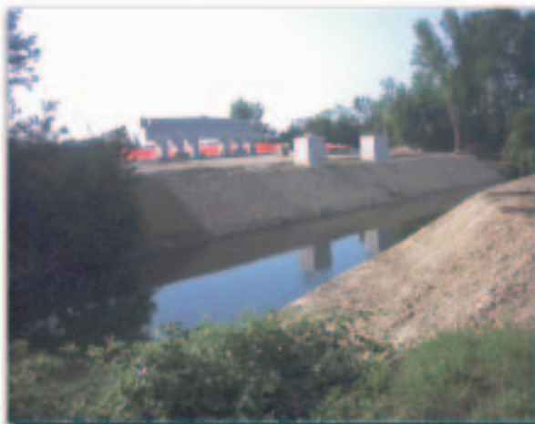
Pile del ponte sul Brentella (lato est)
