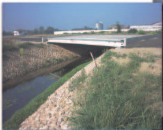
Ponte su canale Porra (luce 21 metri)
