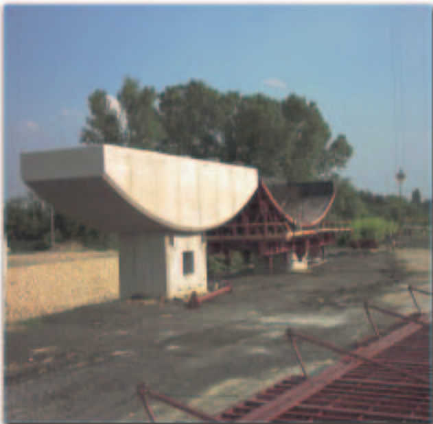
Ponte sul Brentella: le due pile centrali, lato Ovest
