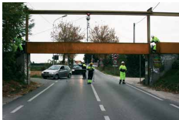
La chiusura delle paratie mobili sulla provinciale Limena-Vigodarzere
